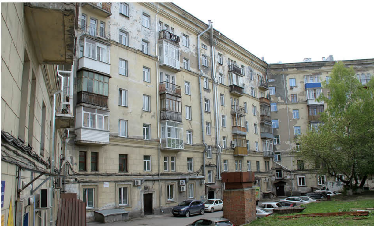
Договор с подрядной организацией по проведению капитального ремонта в доме № 159 по Красному проспекту был расторгнут по решению мэрии
