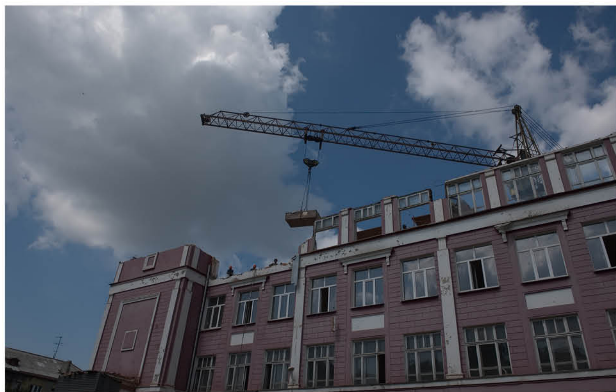
Масштабная реконструкция школы № 82 находится под контролем муниципалитета
