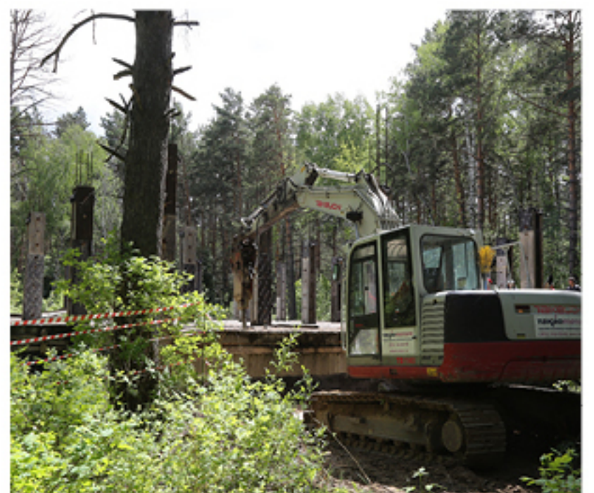
Снос самовольной постройки на территории Завельцовского парка
