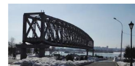
3 Памятник первому мосту через р. Обь
