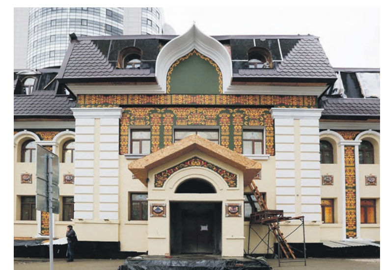
В 2017 году закончили реконструкцию городских бань № 8
