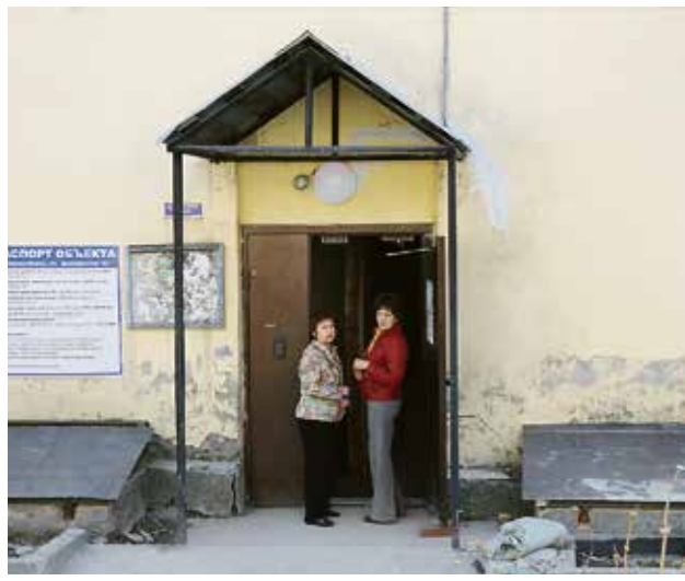
Почти 600 домов дождутся ремонта в этом году | ФОТО МИХАИЛА ПЕРИКОВА
