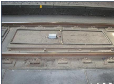
Внешний вид индуктивного датчика, в виде петли установленный открытым способом
