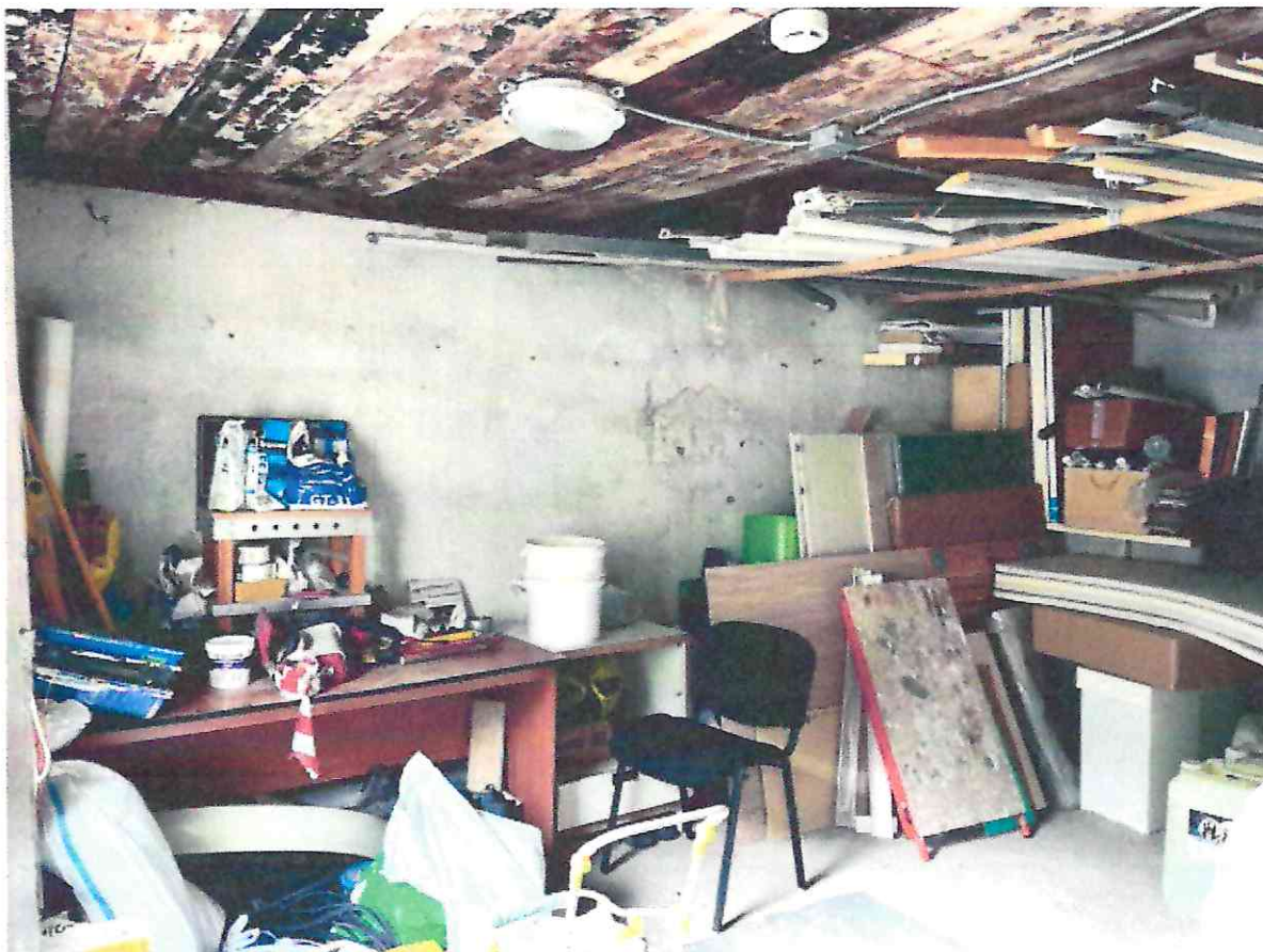
Фото № 14: Помещение в здании овощехранилища.
