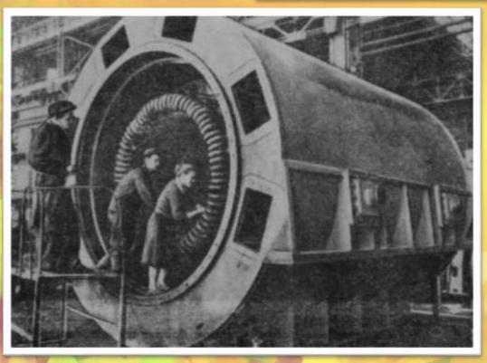
17 сентября – на Новосибирском турбогенераторн ом заводе изготовлен первый турбогенератор мощностью в 60 тысяч киловатт.
