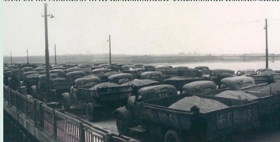
Груженые песком автомобили на мосту в ходе испытаний, октябрь 1955 г. НГА.Ф.Ф-362.Оп.2.Д.4.Л.6.
