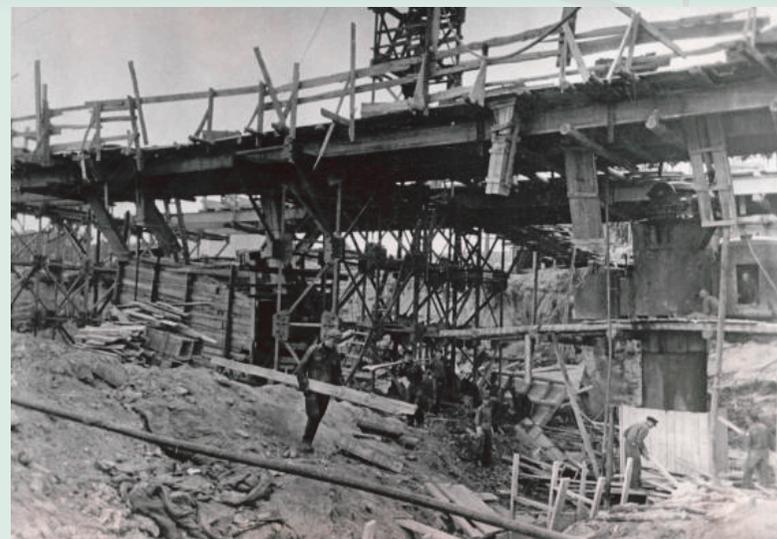
Опора № 8 в ходе разборки аппаратов по завершении кессонирования,
