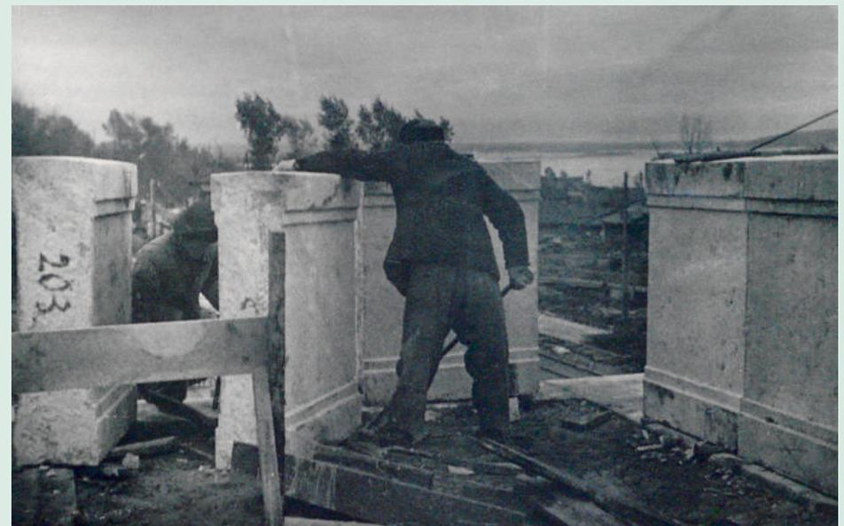
Монтаж бетонных ограждений в эстакадной части моста, 1955 г. НГА.Ф.Ф-362.Оп.2. Д.4. Л.6об.
