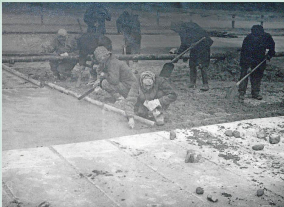
Рабочие в процессе бетонирования дорожного полотна моста, 1955 г. НГА.Ф.Ф-362.Оп.2.Д.4.Л.7
