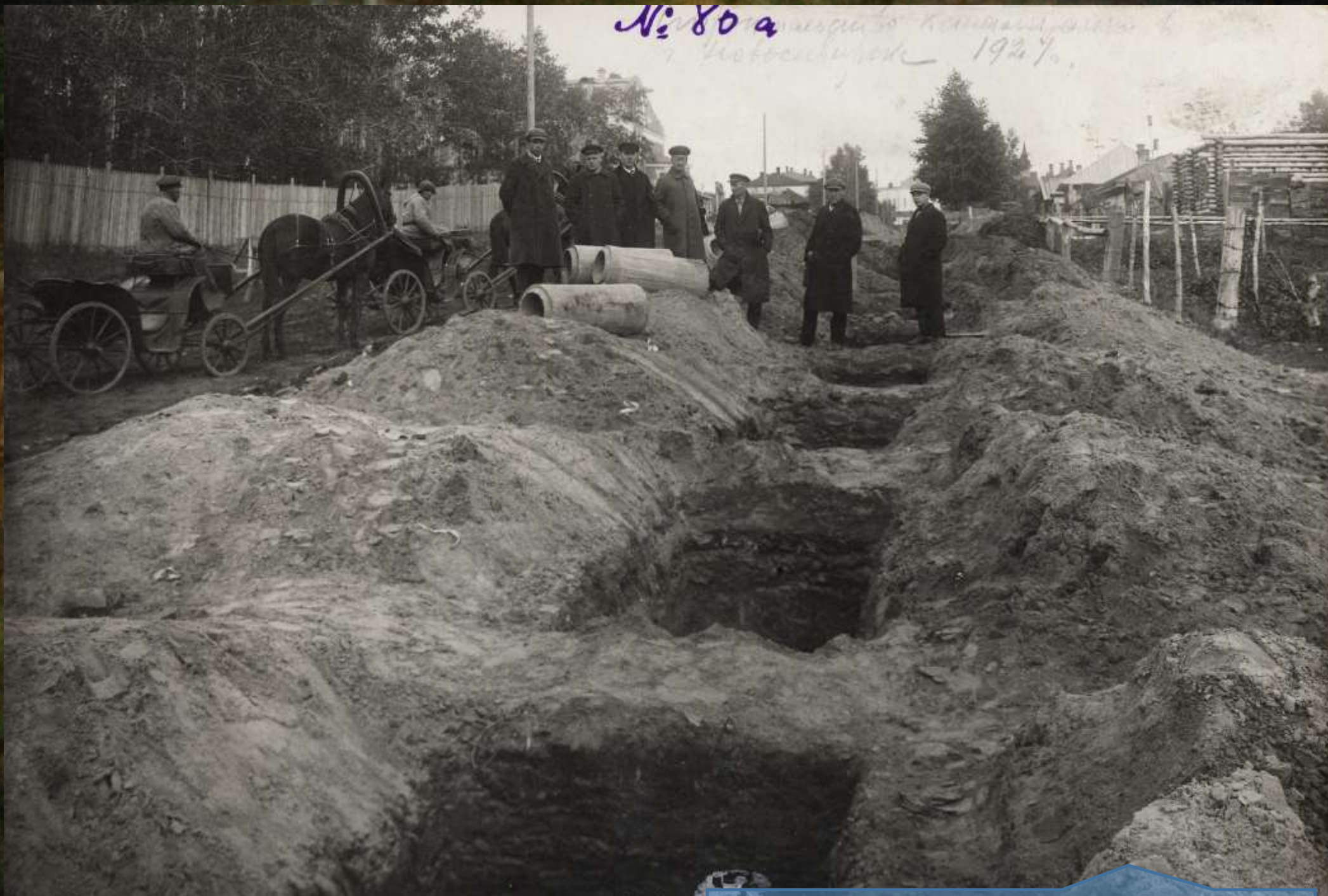
Укладка канализационного коллектора по ул. Бийской (сейчас – ул. Депутатская). 1927 г.
