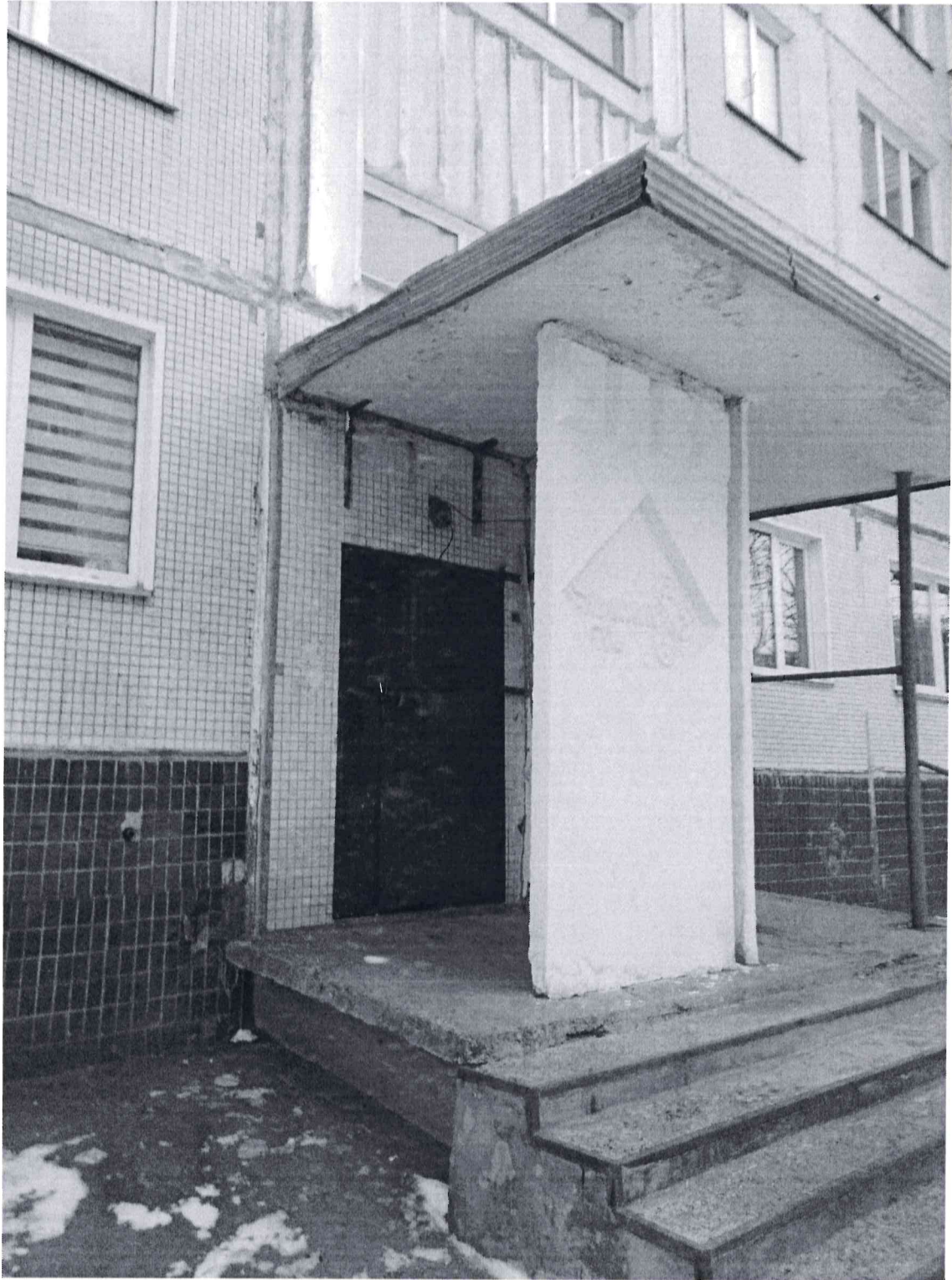
Фото 11. Подъезд №12. Дополнительные элементы крепления вертикальной панели и панели навеса (козырька) входа к панели наружной стены здания.
