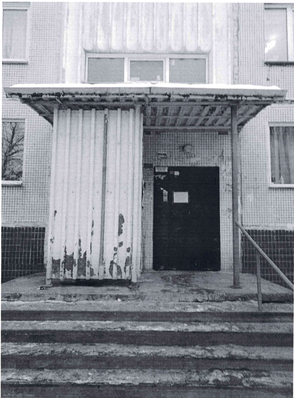
Фото 9. Конструкции входа в подъезд №11 выполненные из металлических прокатных элементов и профилированного листа.
