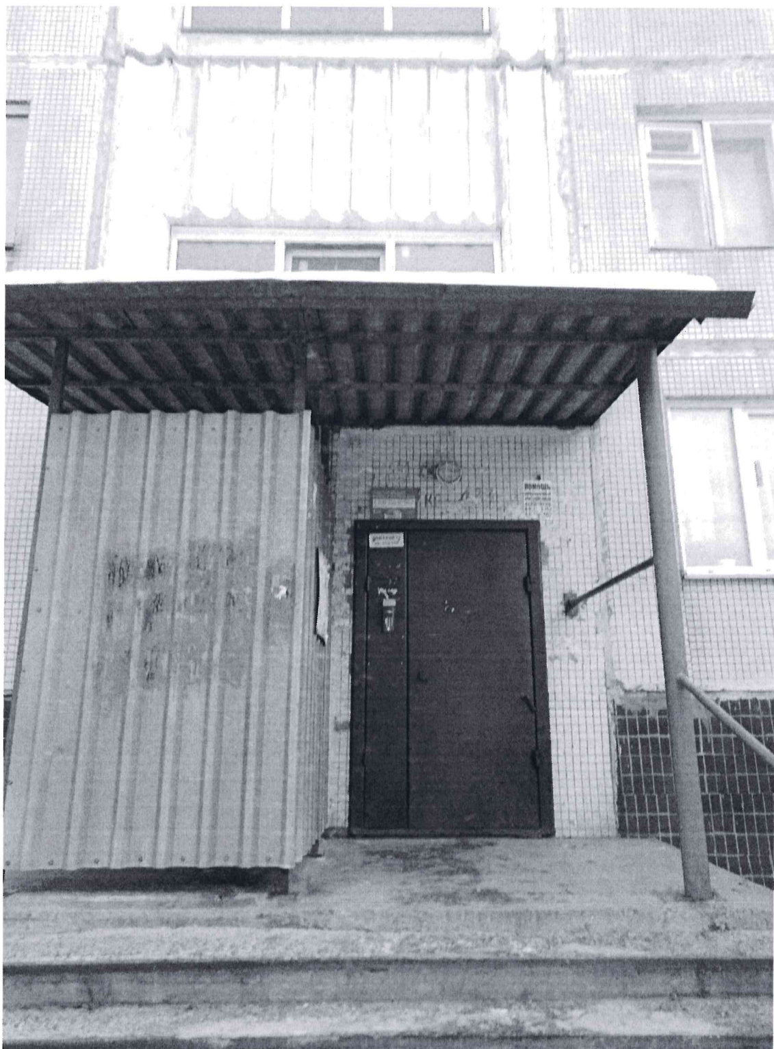
Фото 12. Конструкции навеса выполненные из прокатных элементов и профилированного листа. Подъезд №13.
