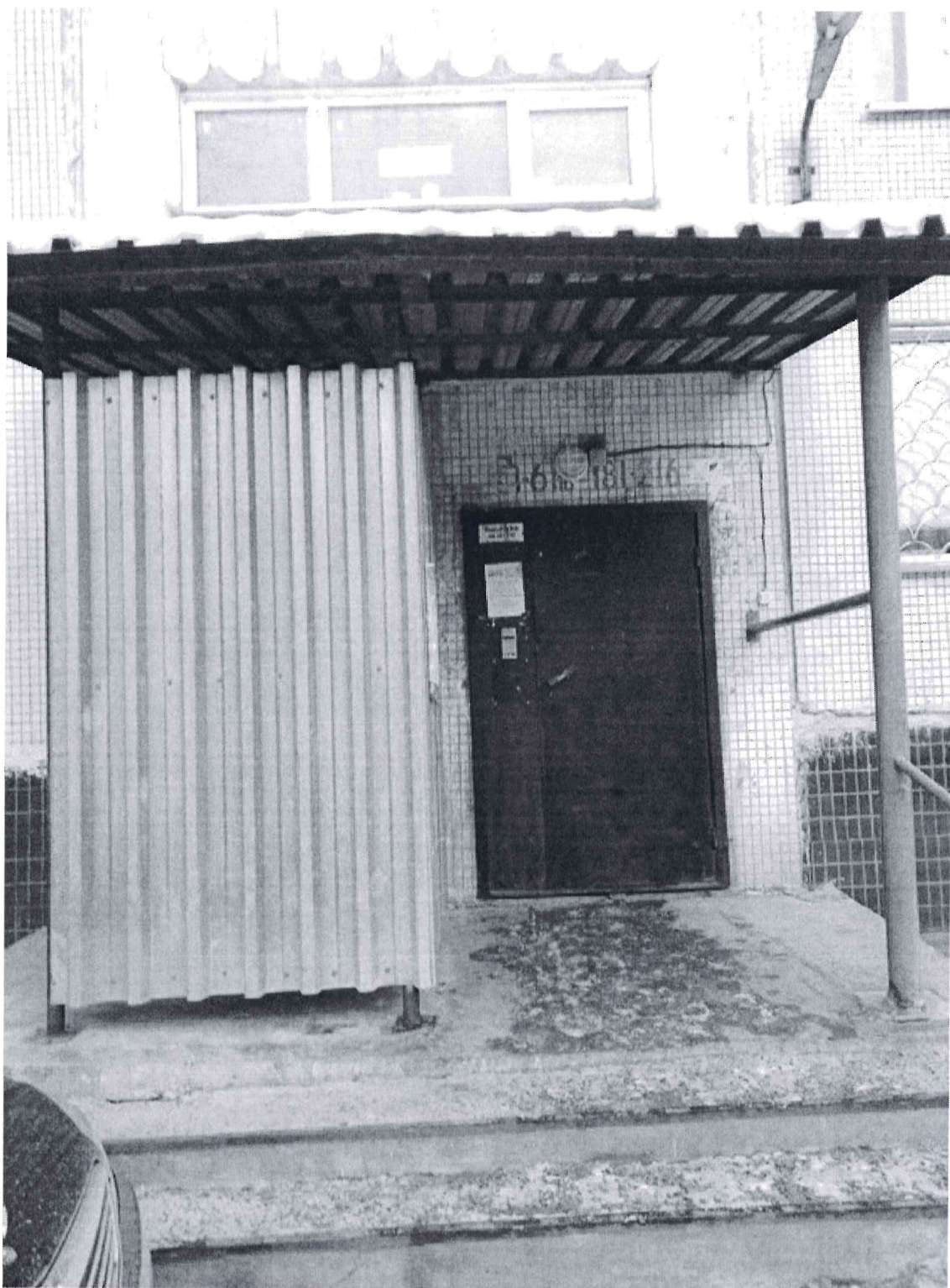
Фото 2. Конструкции входа подъезда №6 выполненные из прокатных профилей.
