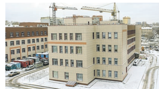
Завершён капитальный ремонт школы № 82 на ул. Гоголя, 195: там появится пристройка на 700 мест | ФОТО ПАВЛА КОМАРОВА
