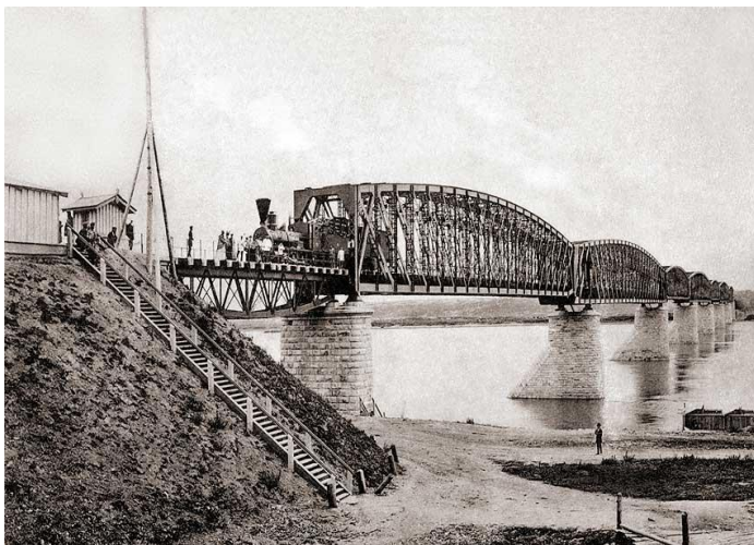
Железнодорожный мост через Обь
