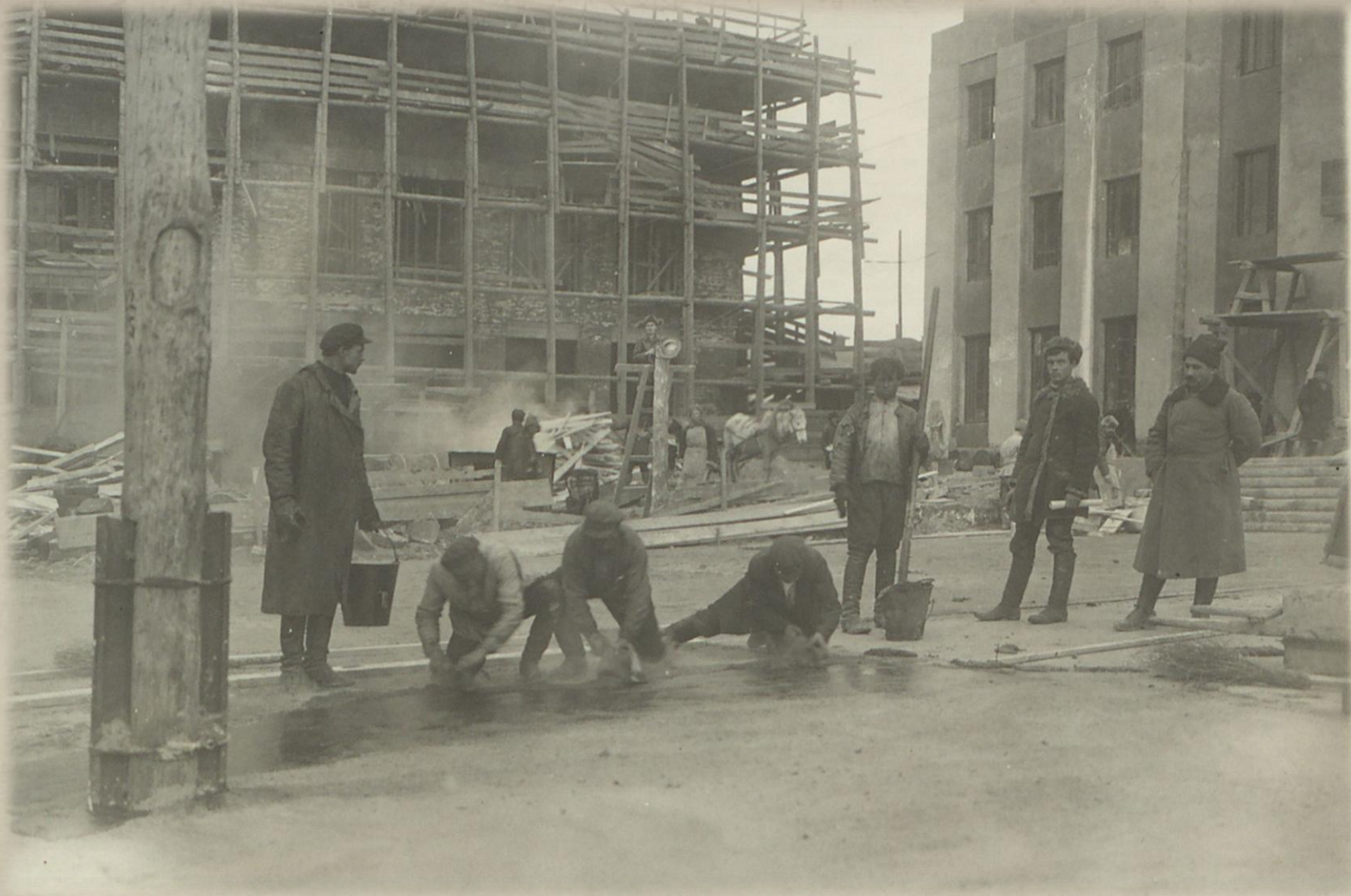
Фрагмент проведения работ по укладке асфальта
