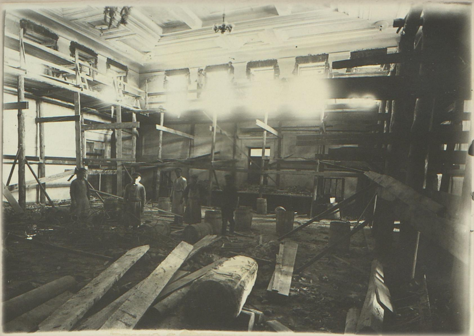
Вид большого зала во время устройства парапета
