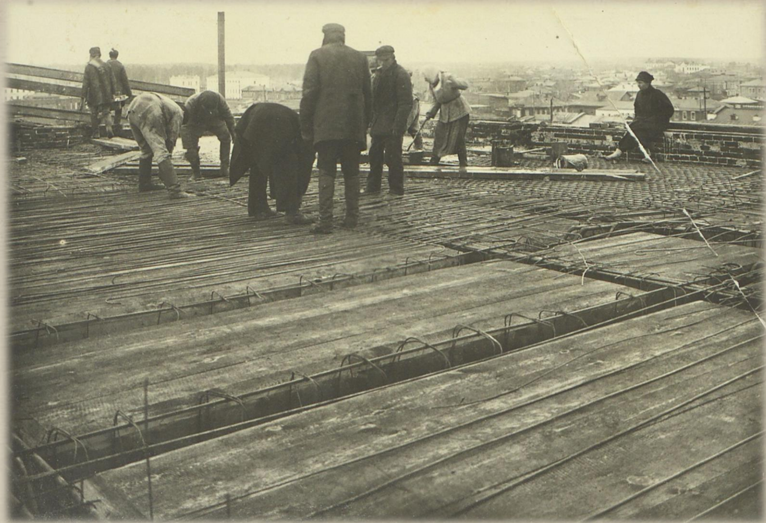
Фрагмент проведения работ по укладке арматуры
