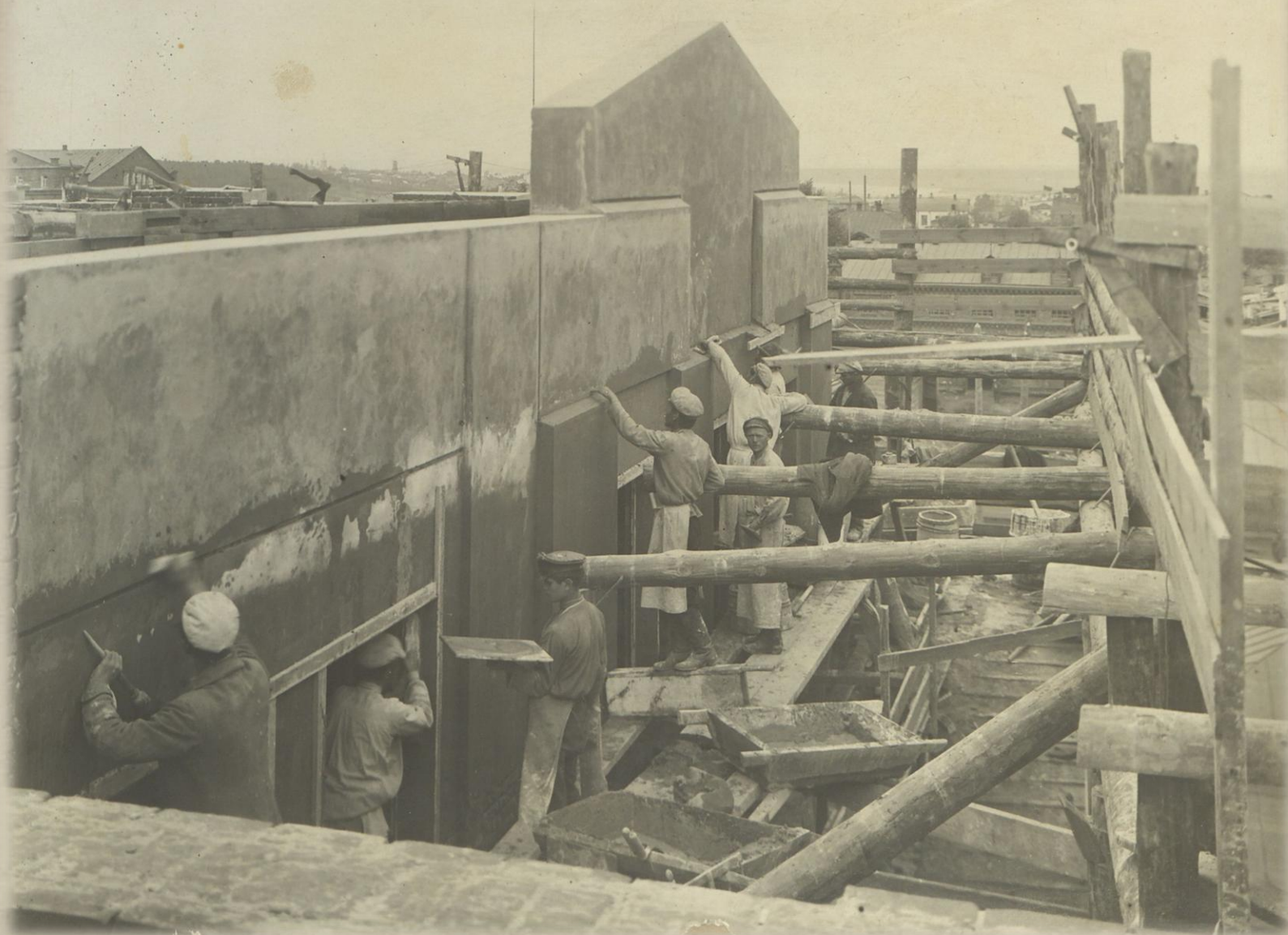
Фрагмент проведения работ по оштукатуриванию бокового фасада
