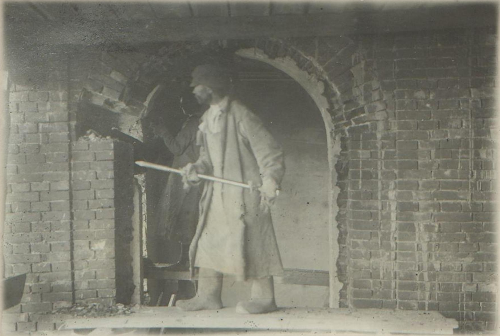
Фрагмент проведения работ по расширению окон
