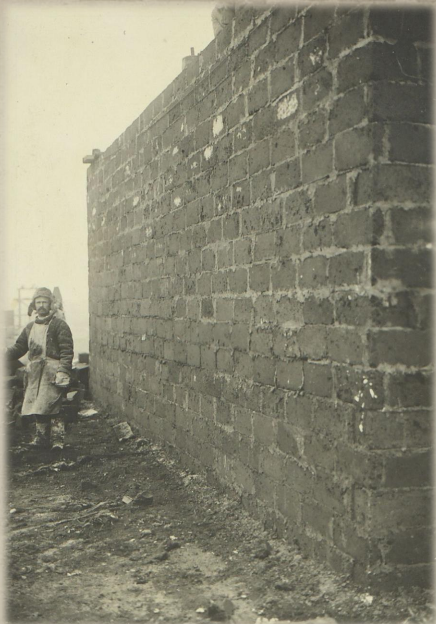
Фотоснимок рабочего, стоящего около возведенной стены четвертого этажа здания
