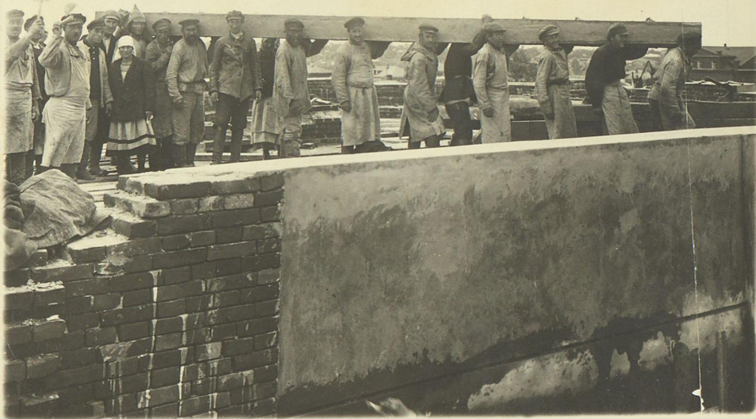
Фрагмент перемещения группой рабочих балки к месту её укладки
