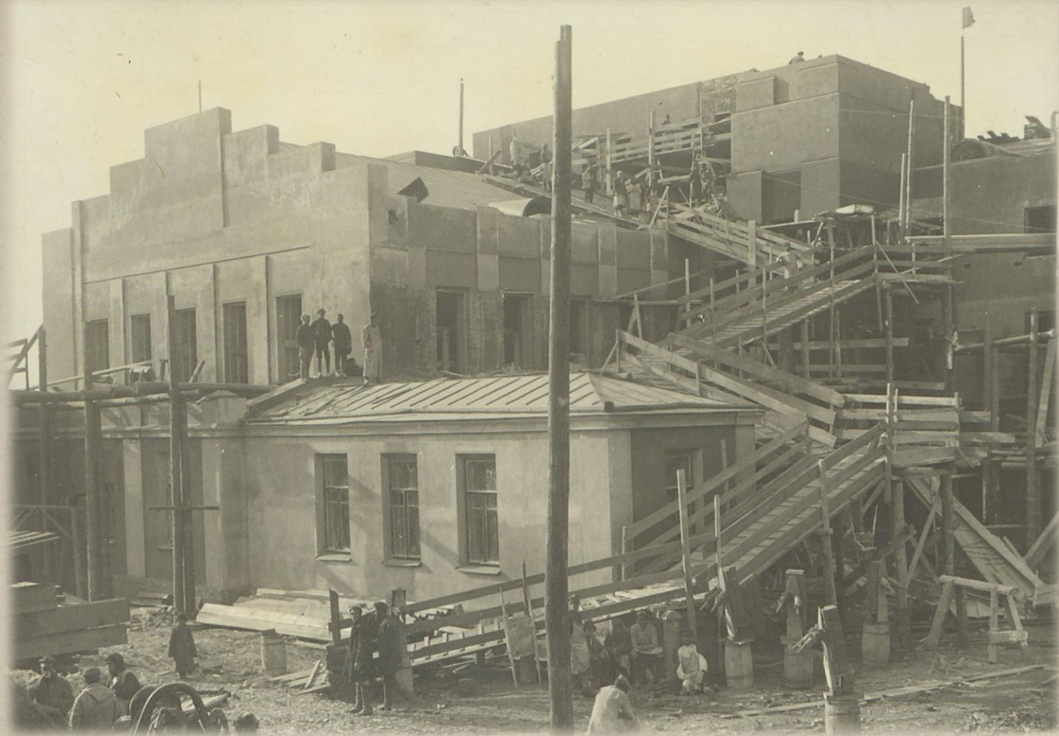
Вид на здание с северо-восточной стороны
