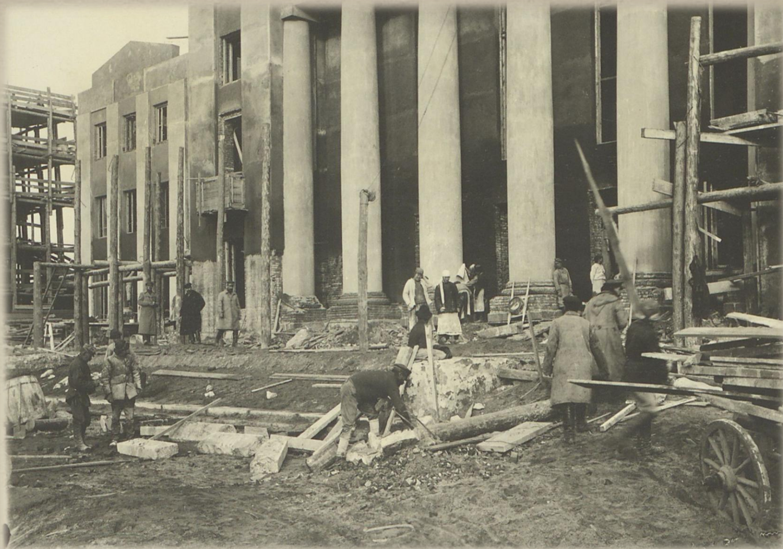
Фрагмент проведения работ по обустройству парадного входа
