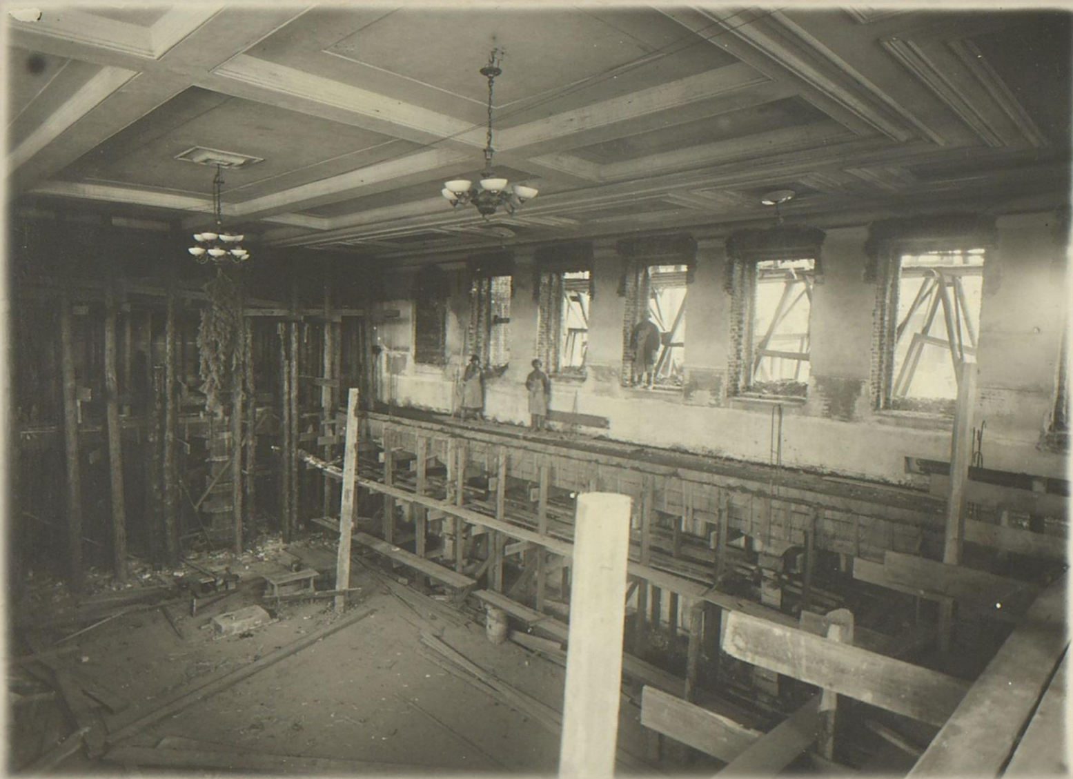
Фрагмент проведения работ по бетонированию балкона в одном из залов
