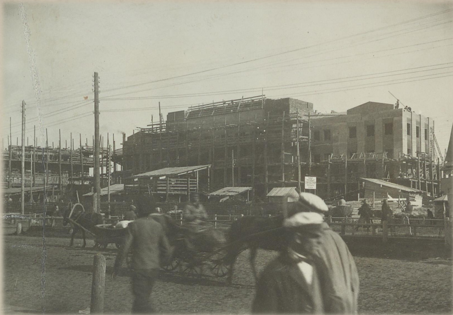
Общий вид здания на завершающей стадии реконструкции
