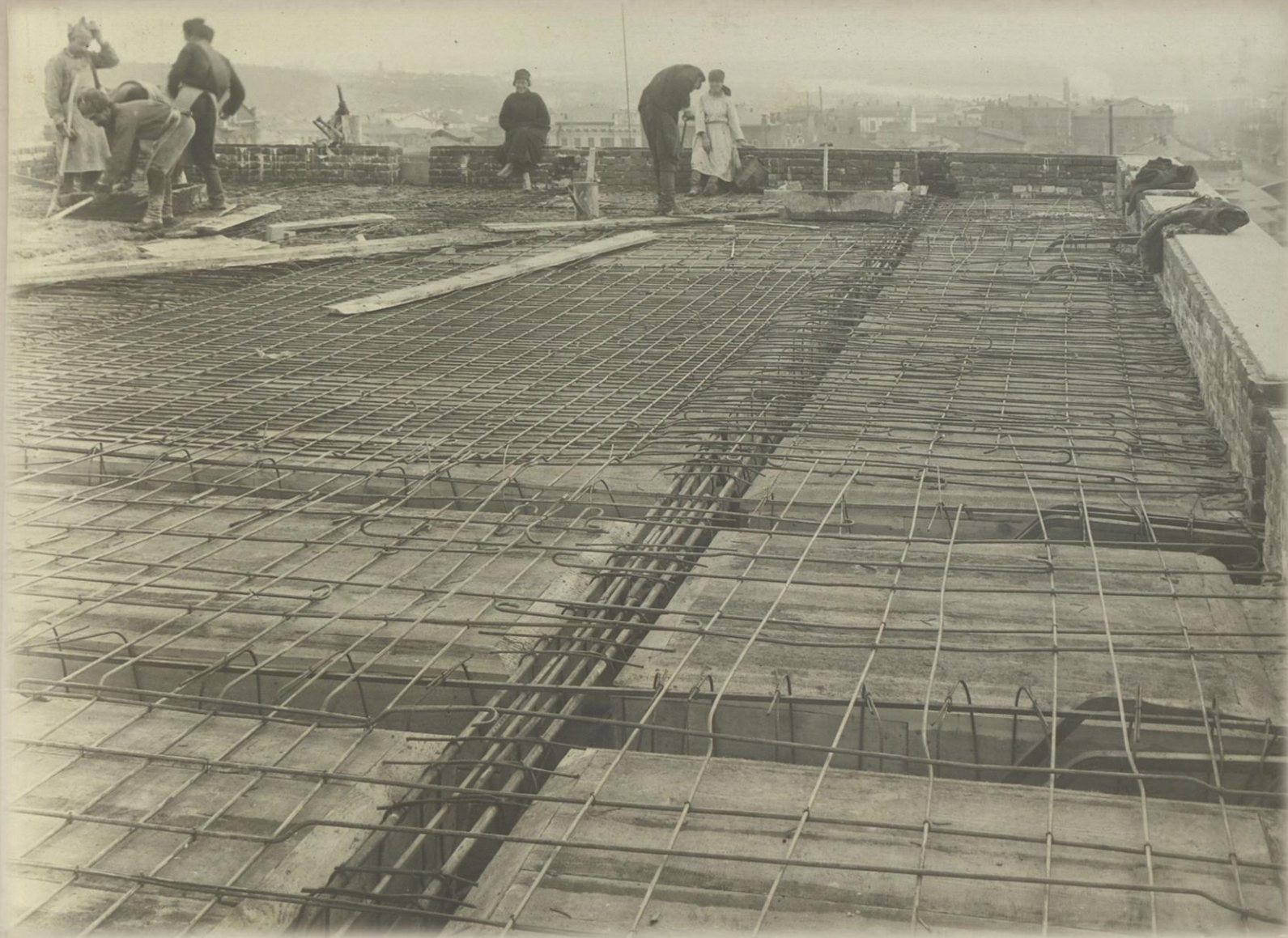
Фрагмент проведения работ по укладке арматуры
