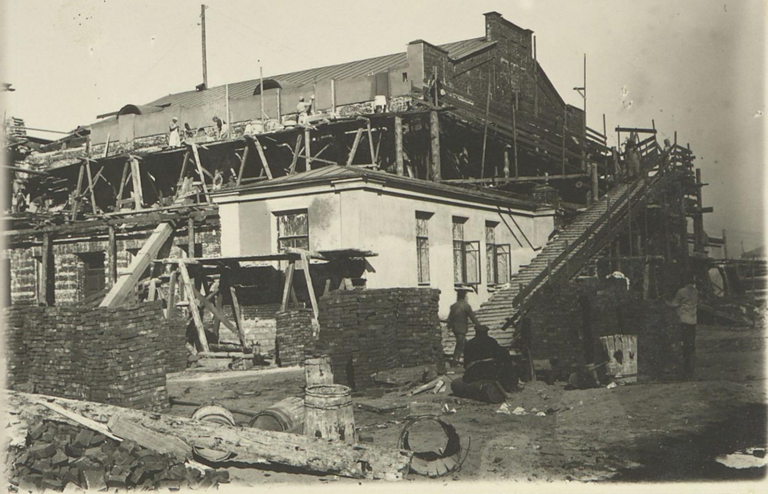
Общий вид на одну из частей здания во время проведения штукатурных работ парапета
