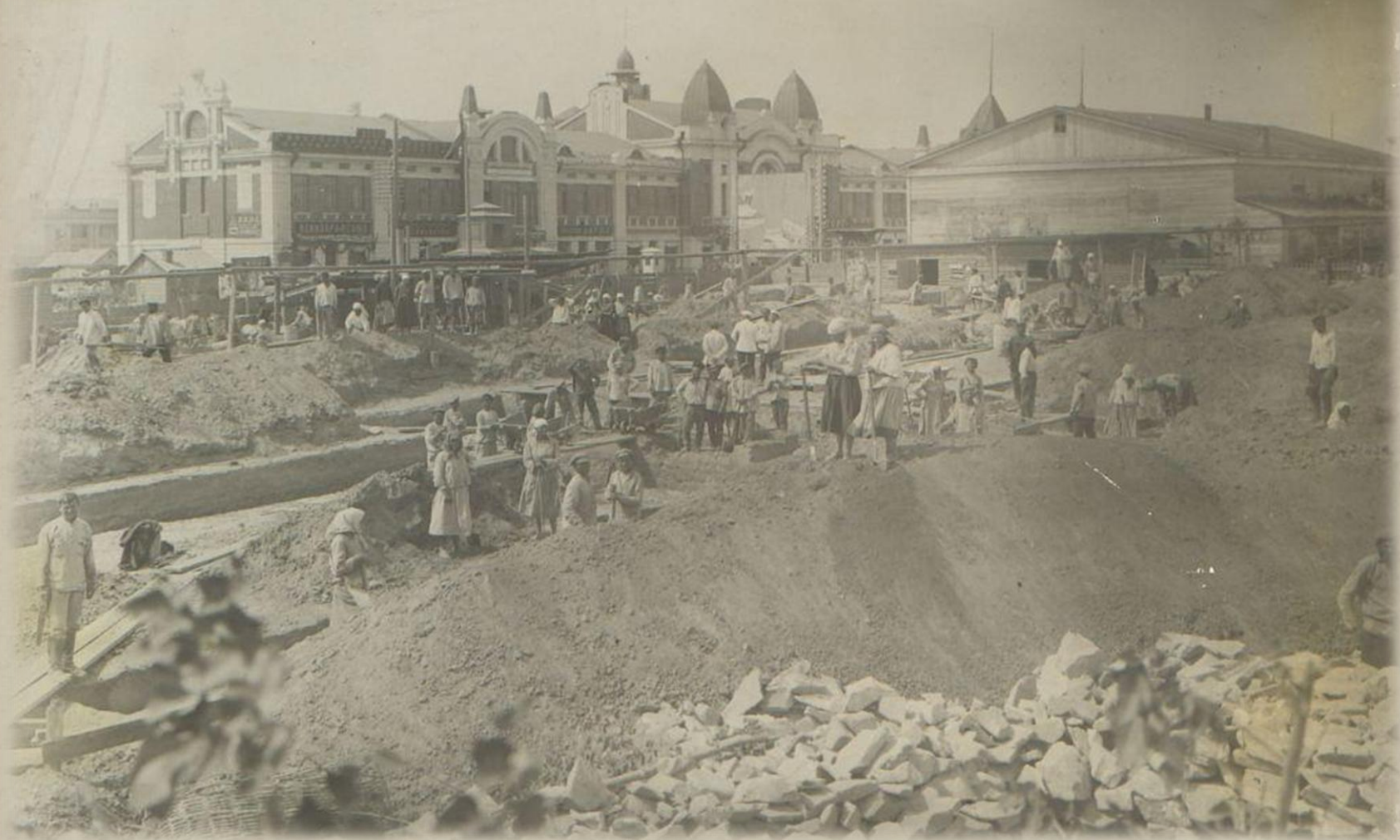
Фрагмент начального этапа по обустройству котлована будущего Дома Ленина (1924 г.)
