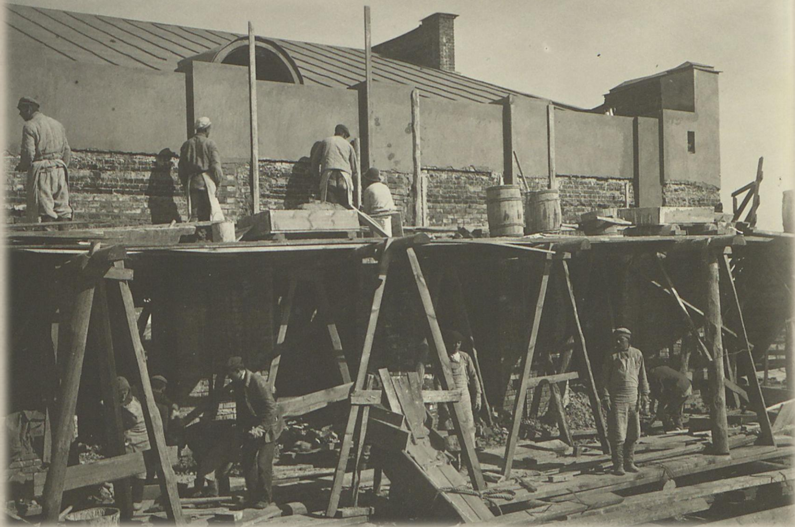
Фрагмент проведения работ по штукатурке парапета
