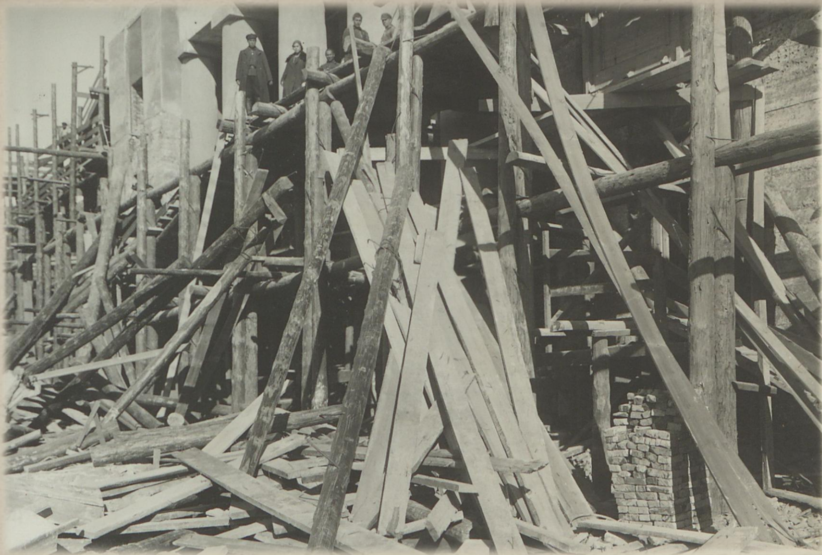
Фрагмент проведения работ по разбору строительных лесов
