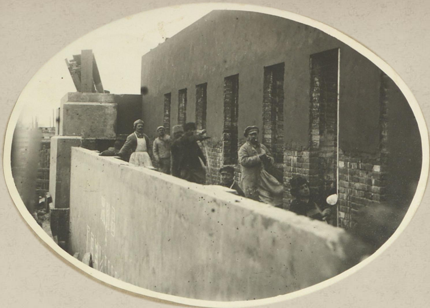
Фрагмент проведения штукатурных работ
