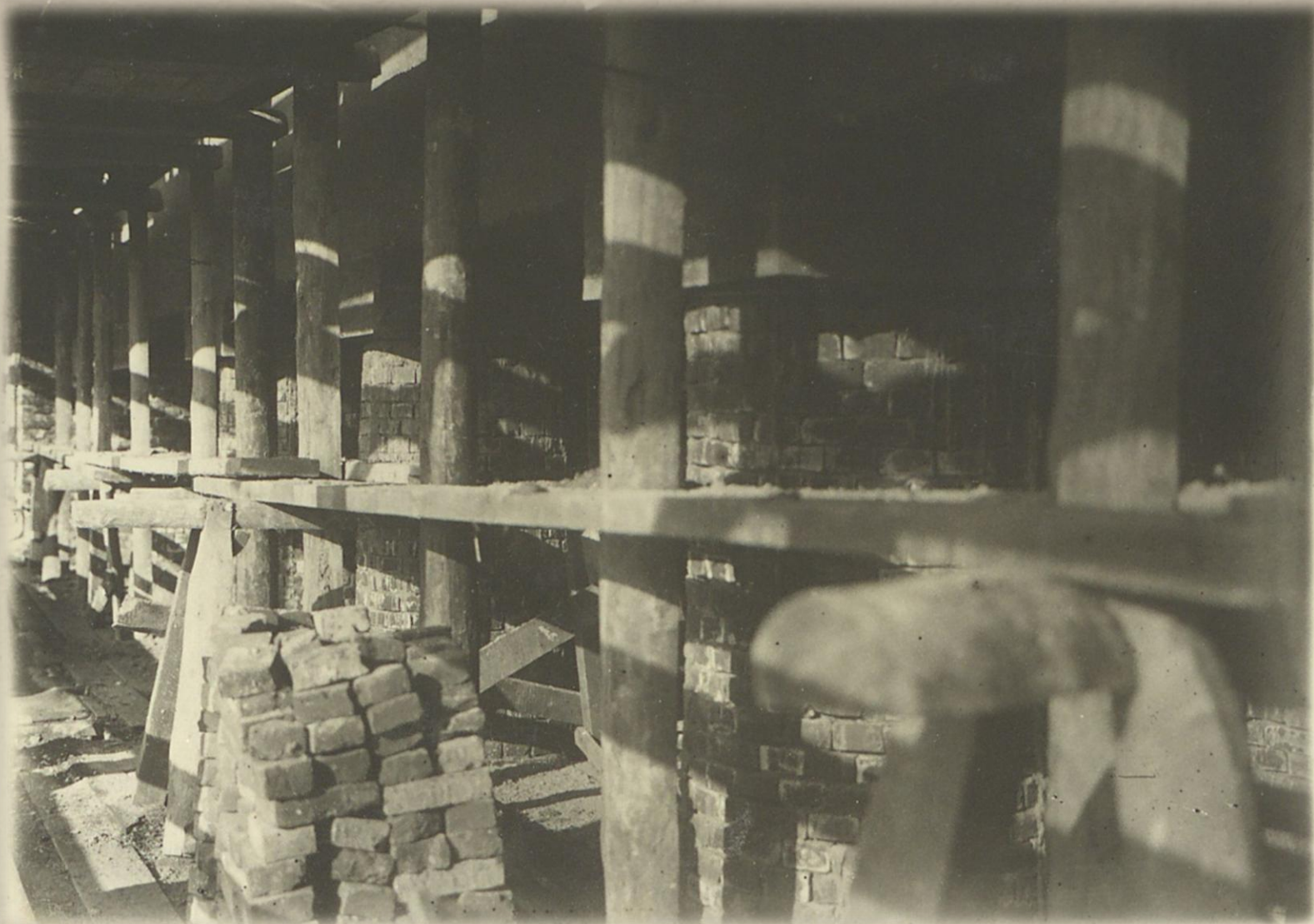
Вид на нижнюю часть кирпичных колонн, частично закрытых строительными лесами
