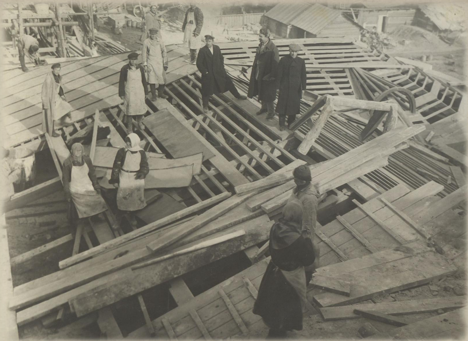
Фрагмент проведения кровельных работ над одним из надстроенных элементов здания
