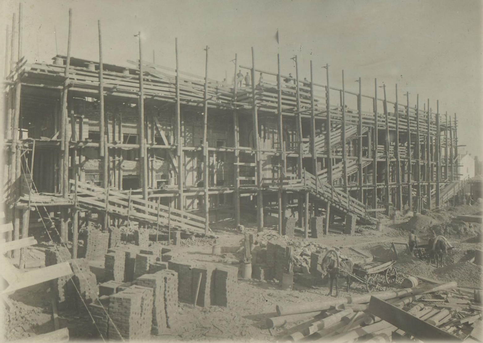
Общий вид здания во время реконструкции
