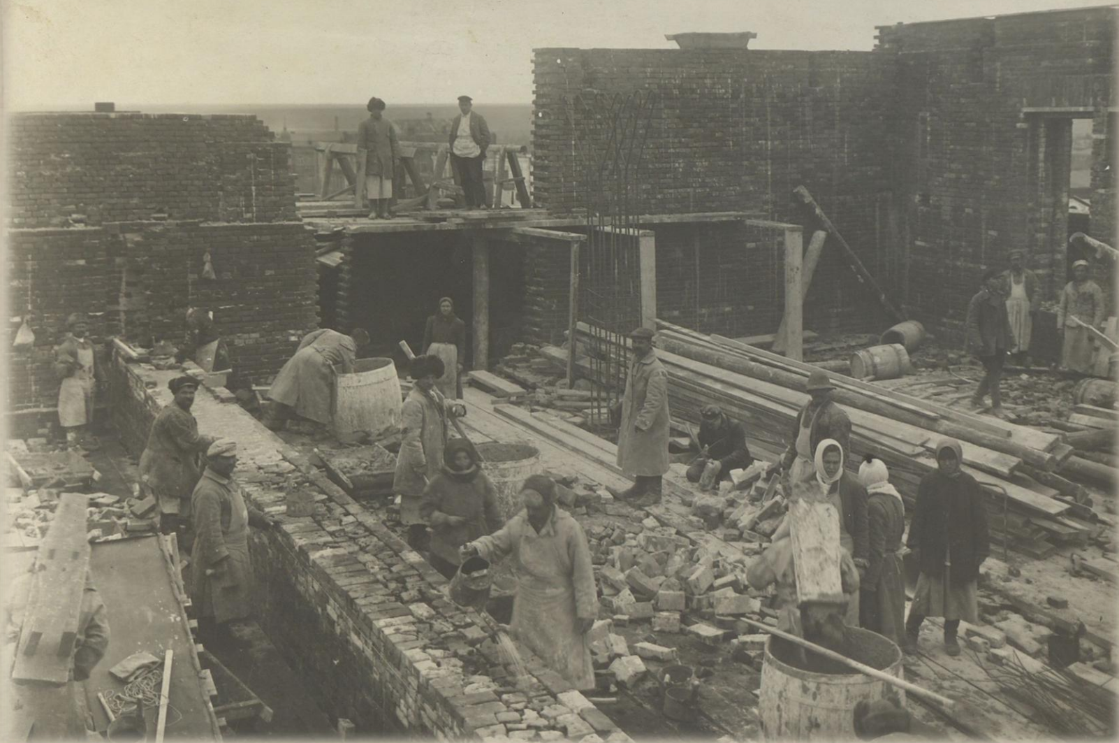
Вид на один из участков строительной площадки при проведении надстройки здания
