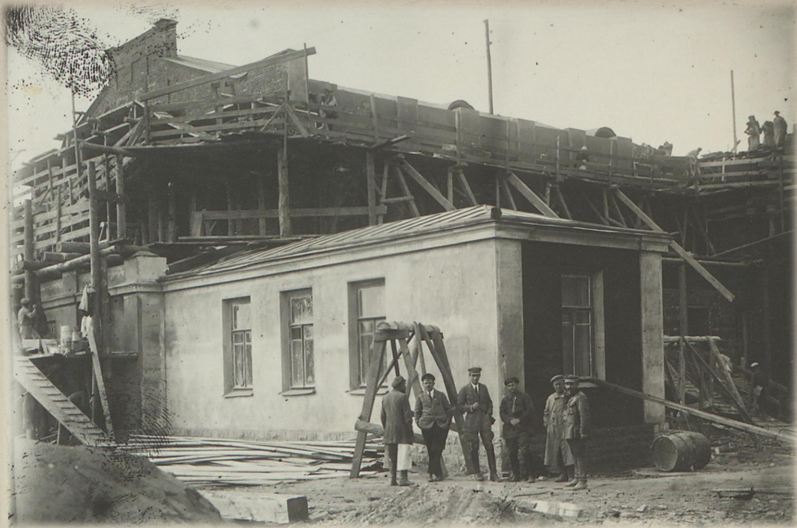
Фрагмент проведения работ по реконструкции одного из крыльев, примыкающих к основному объему здания
