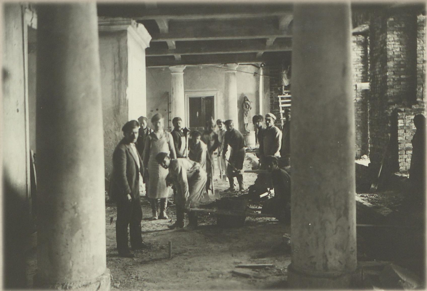
Фрагмент проведения работ по очистке вестибюля от строительного мусора
