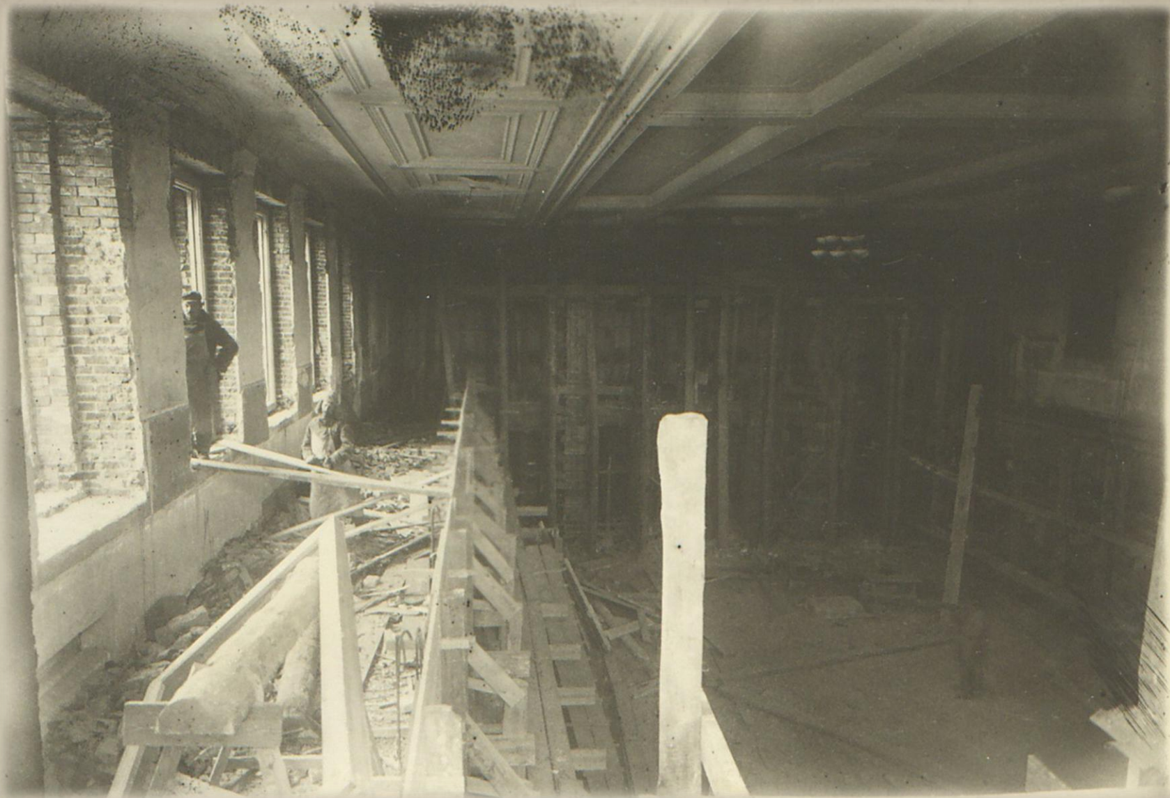
Фрагмент проведения работ по устройству бокового балкона
