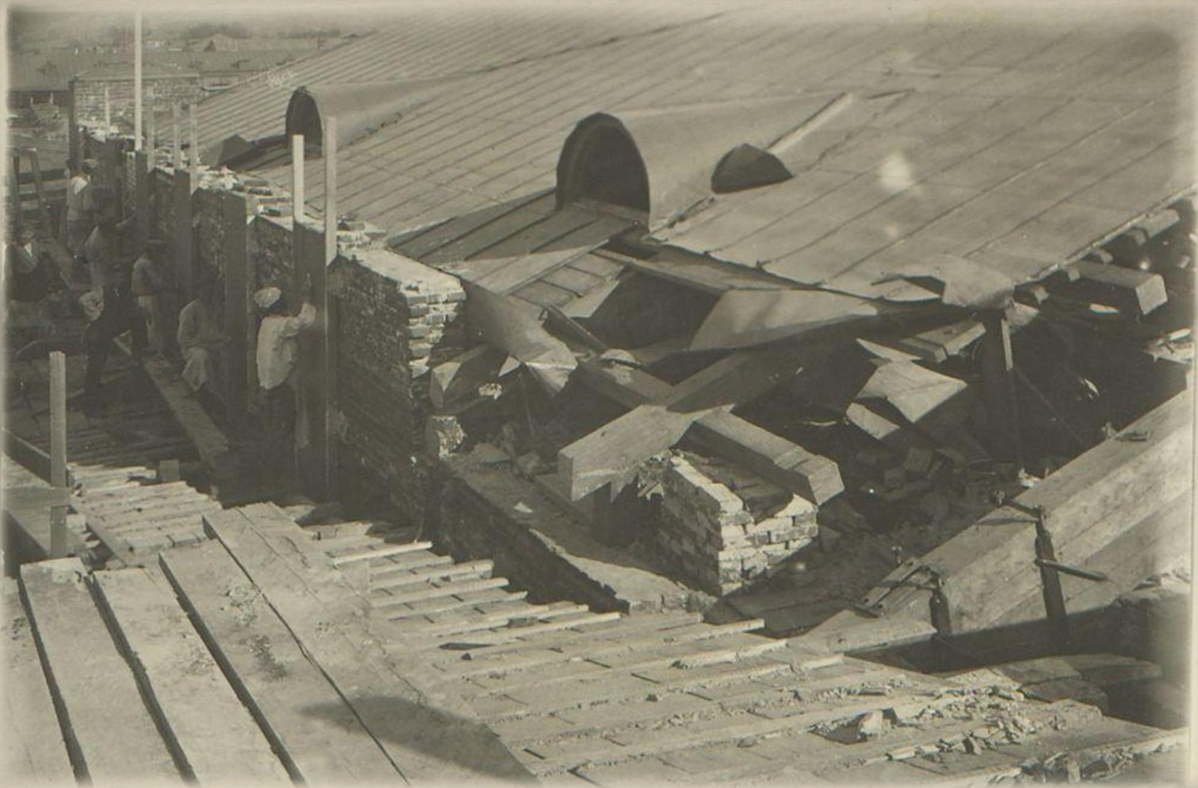
Фрагмент проведения работ по обустройству окон в надстраиваемой части здания
