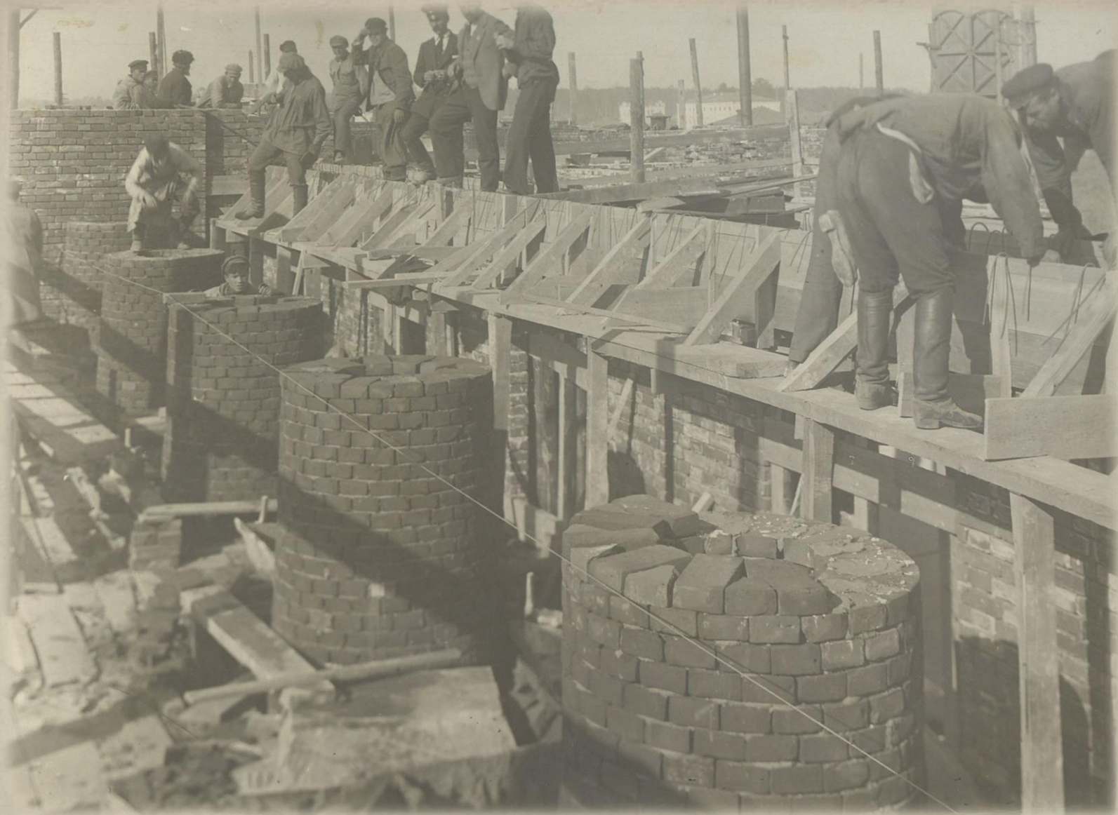
Фрагмент проведения работ по кирпичной кладке колонн
