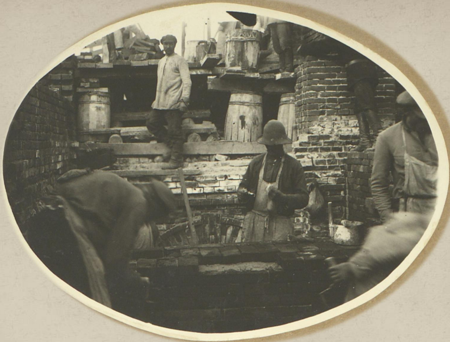
Фрагмент проведения работ по кирпичной кладке стен
