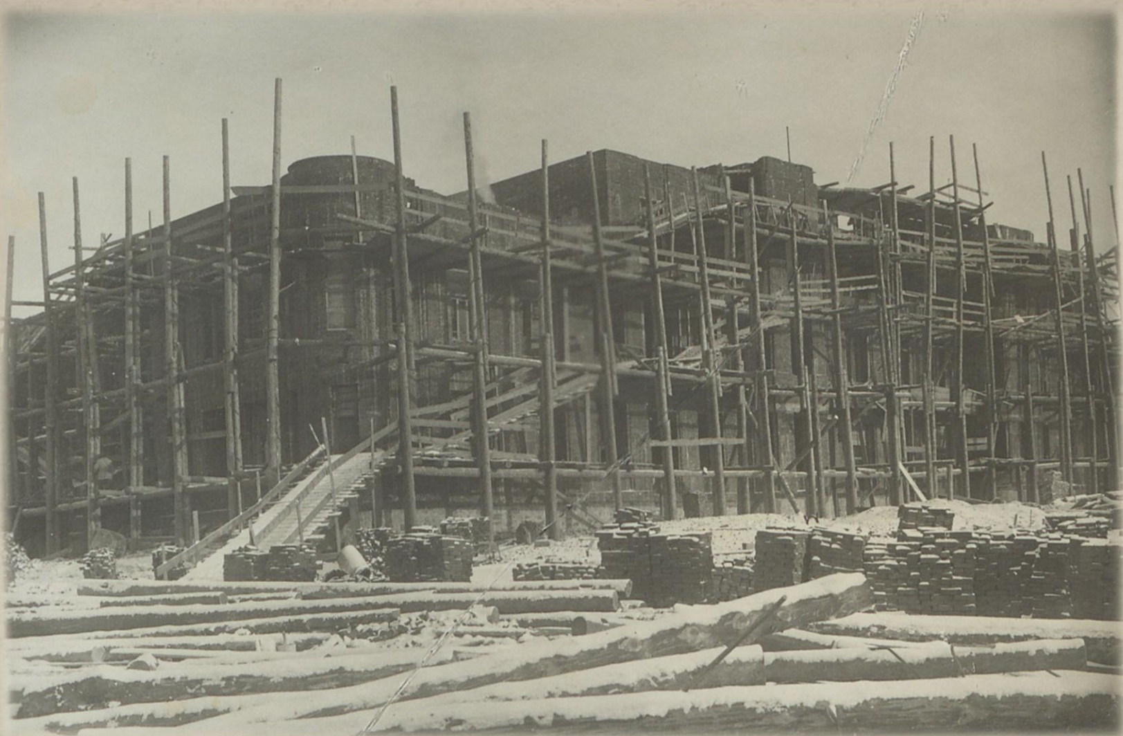
Общий вид одной из частей здания во время реконструкции
