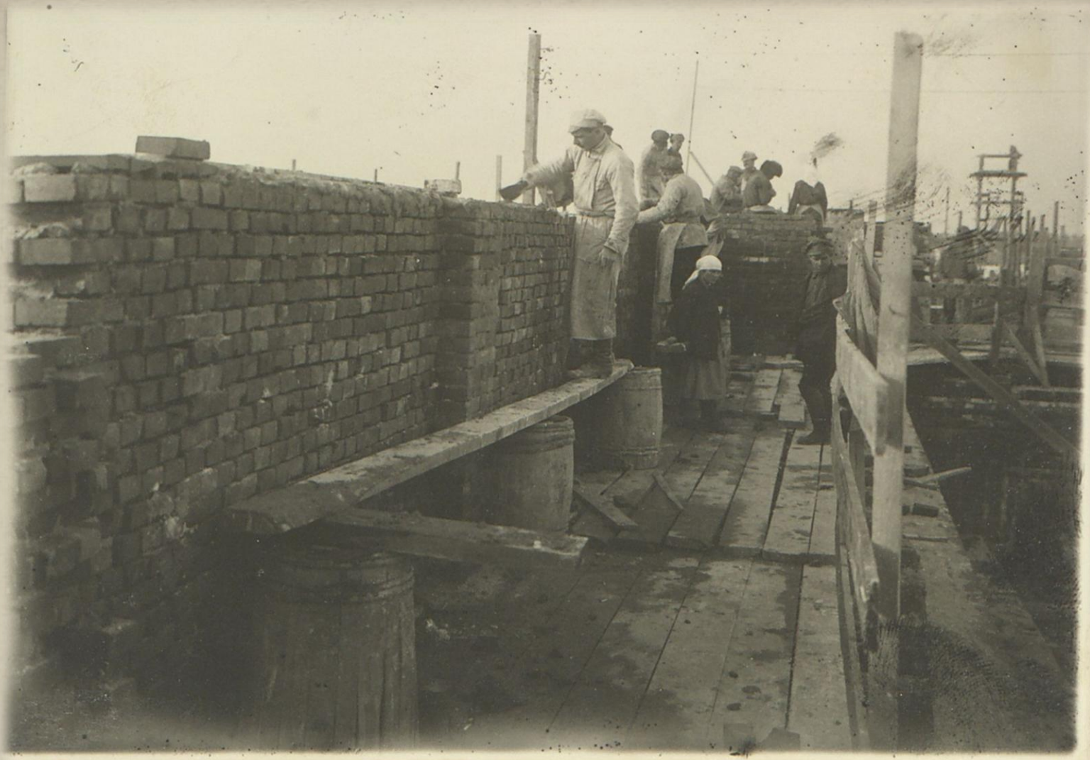
Фрагмент проведения работ по кирпичной кладке стен
