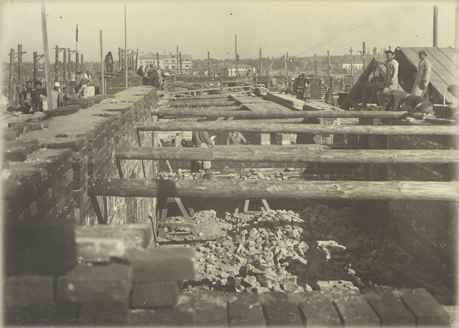
Фрагмент проведения работ по надстройке стен
