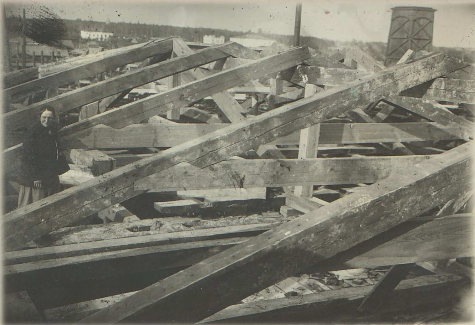
Фрагмент проведения работ по демонтажу крыши
