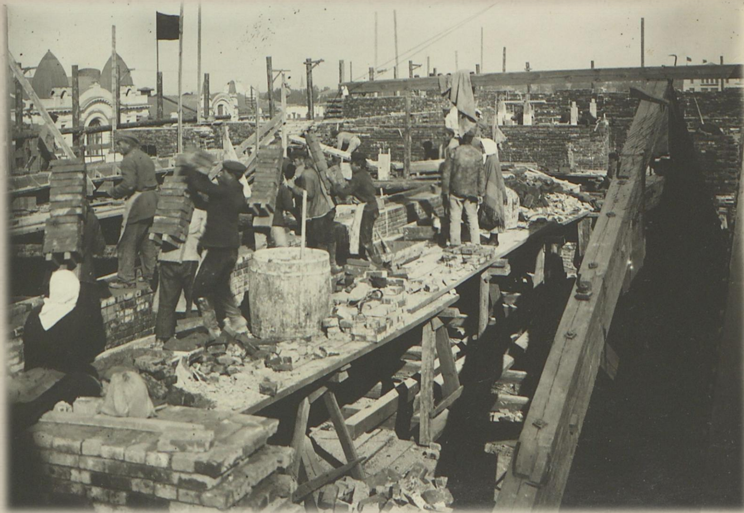
Фрагмент проведения работ по кирпичной кладке стен
