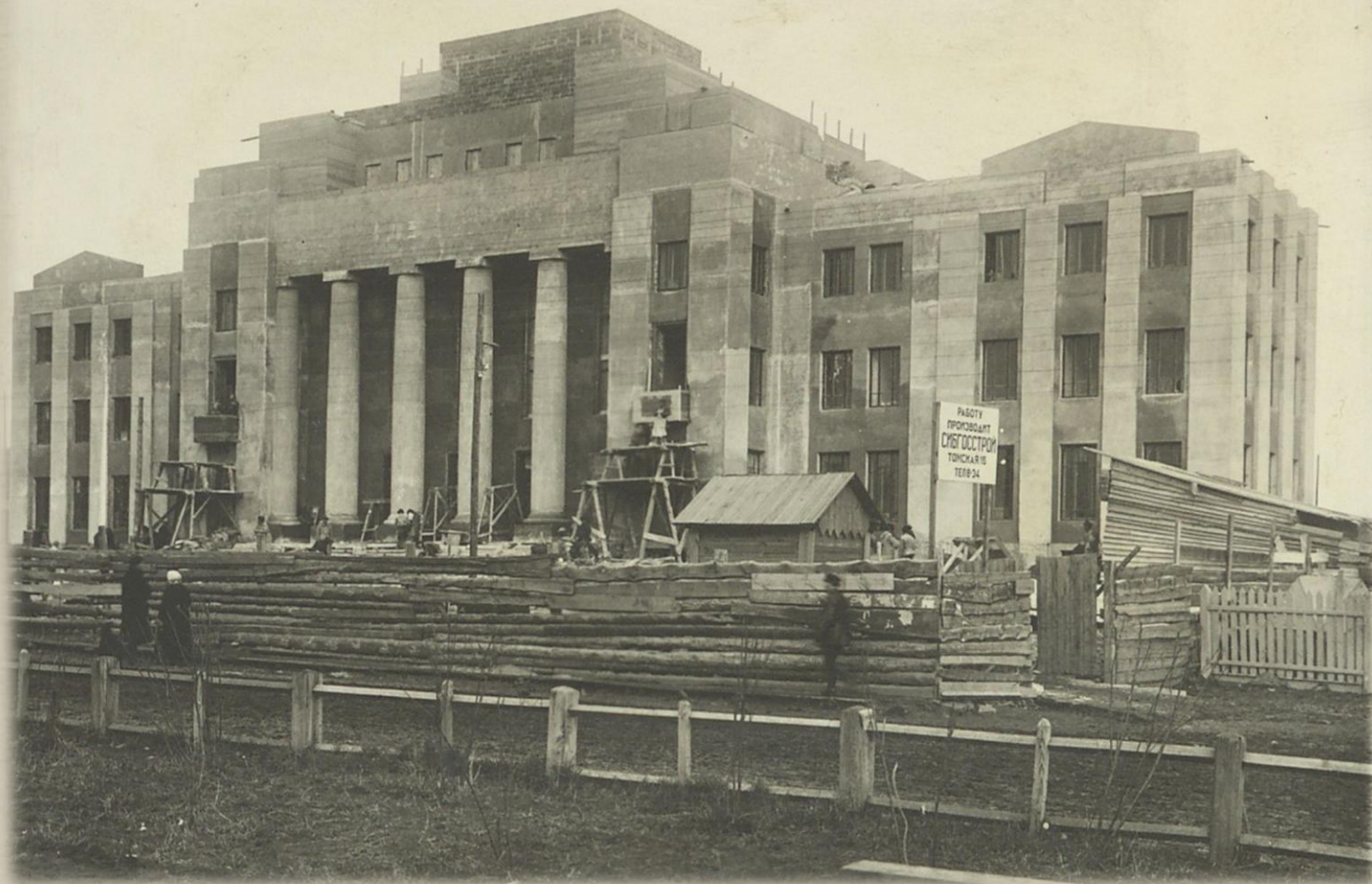
Общий вид здания на завершающей стадии реконструкции
