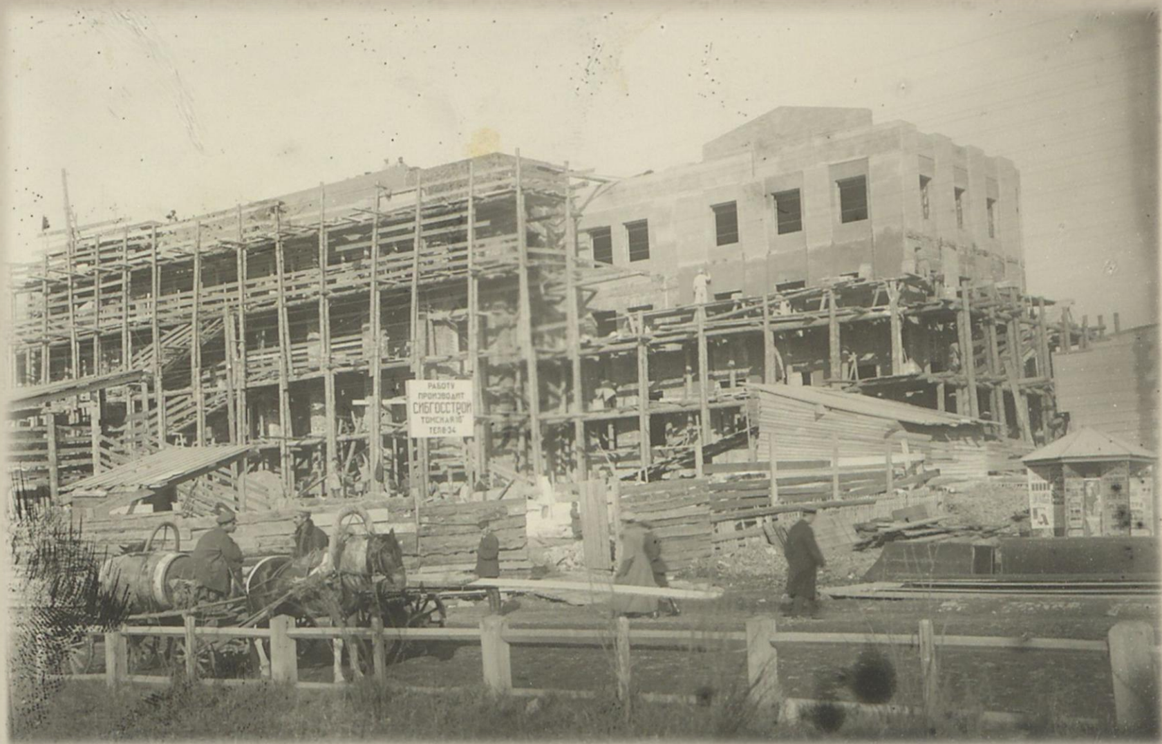
Общий вид здания во время реконструкции
