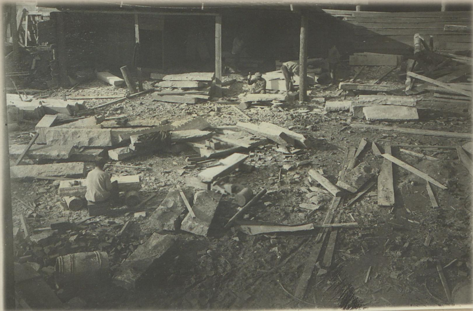
Фрагмент проведения работ по обработке ступеней для лестницы главного входа
