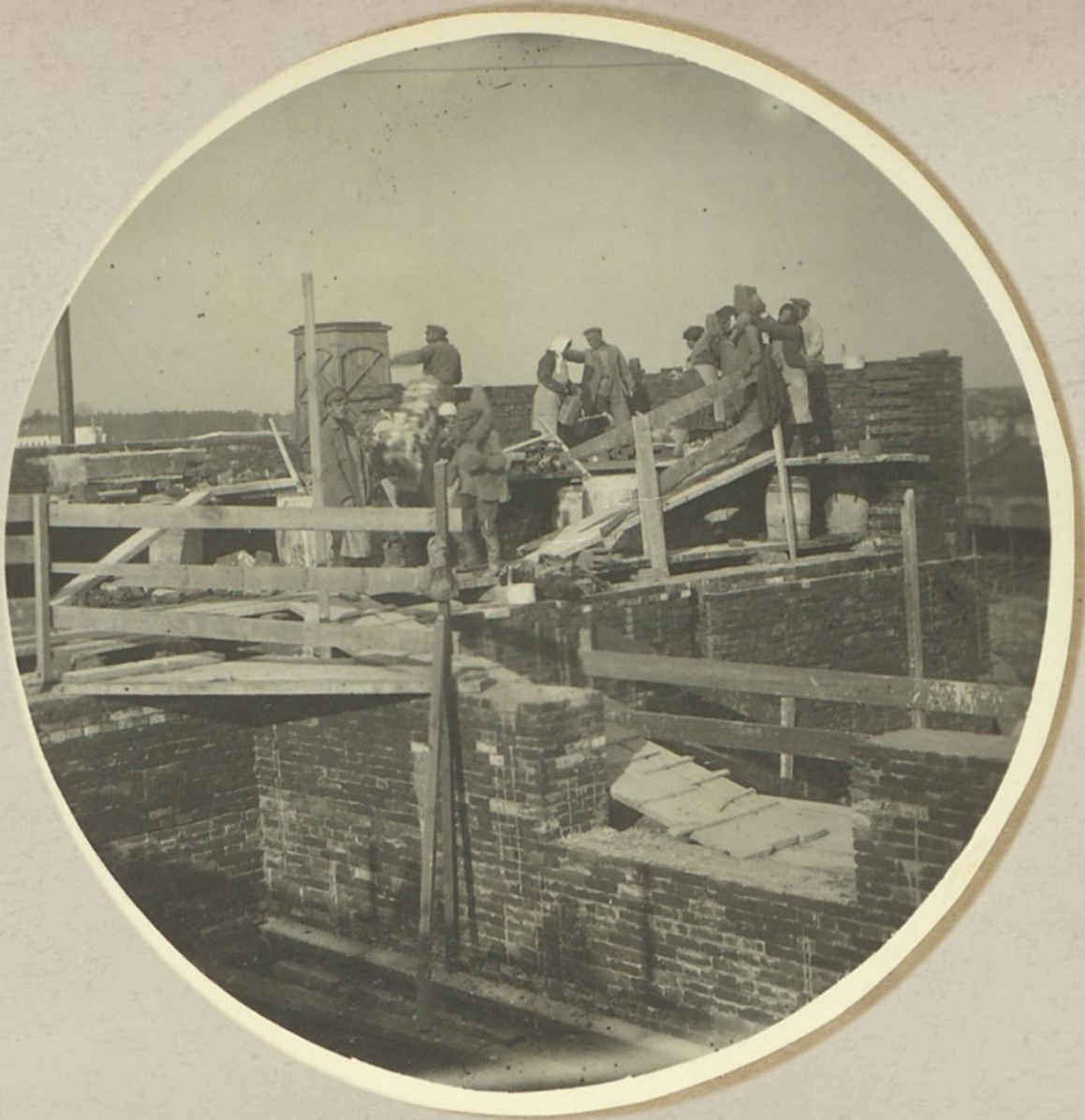
Фрагмент проведения работ по подаче кирпича к месту кладки
