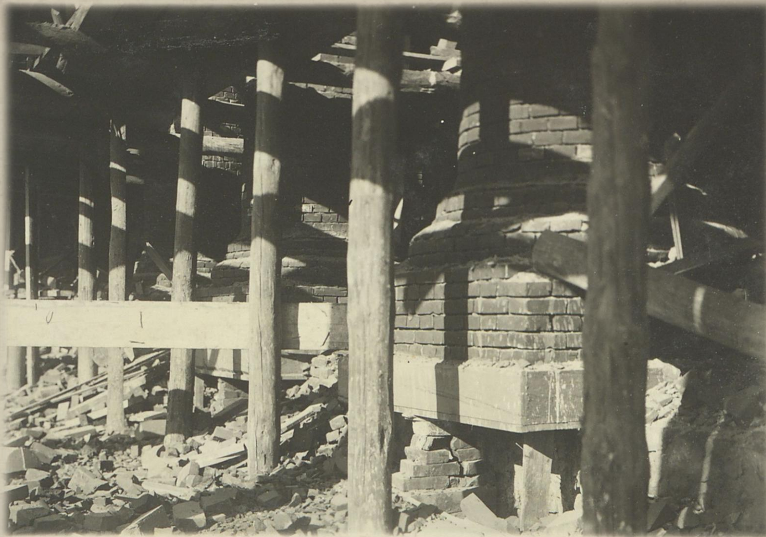
Вид на базу и нижнюю часть кирпичных колонн, частично закрытых строительными лесами
